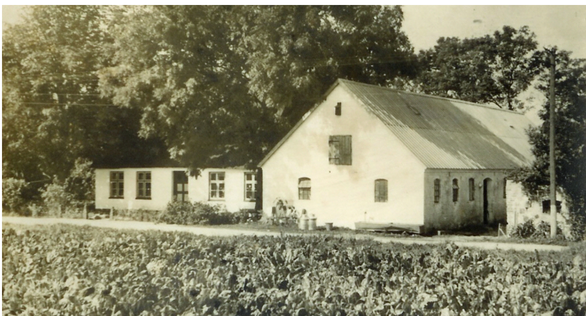
Ejendommen i 1930erne med nyt murværk og nye vinduer samt pandeplader på stalden.
